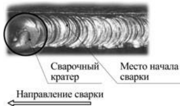
Рис. 7.3. Начало сварки при смене электрода.
